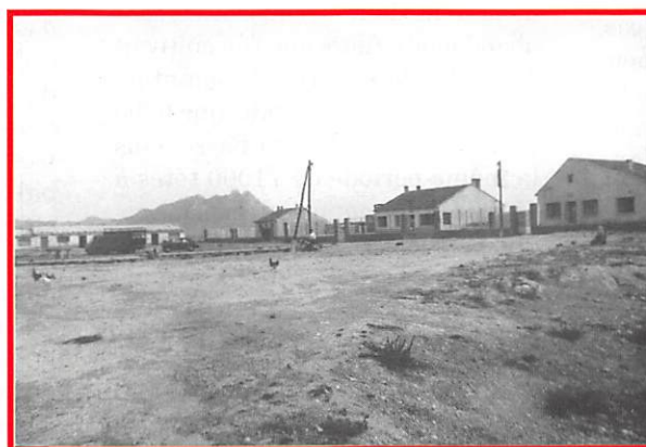
Bâtiments administratifs d'El Meridj
