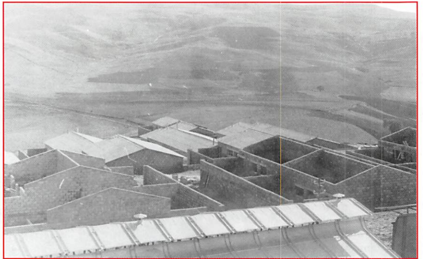
SAS de Condé-Smendou - la cité maghzen en construction (Photo Robert Vairon)
